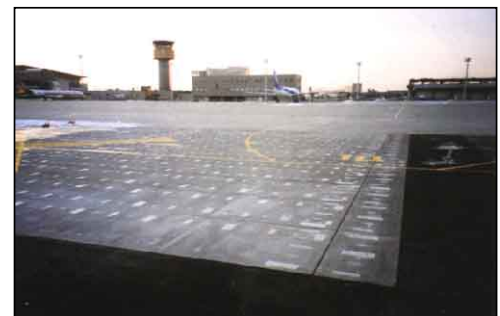
仙台空港誘導路(プレキャスト方式)
