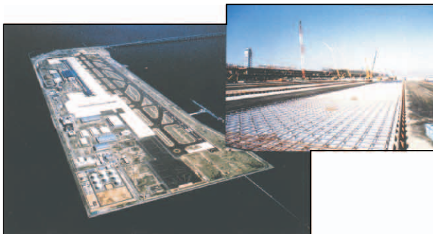
関西国際空港エプロン (現場打ち方式、後設置型リフトアップ方式)
