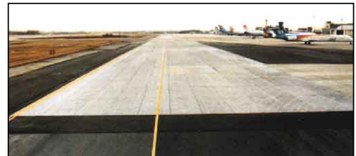
名古屋空港誘導路(プレキャスト方式)
